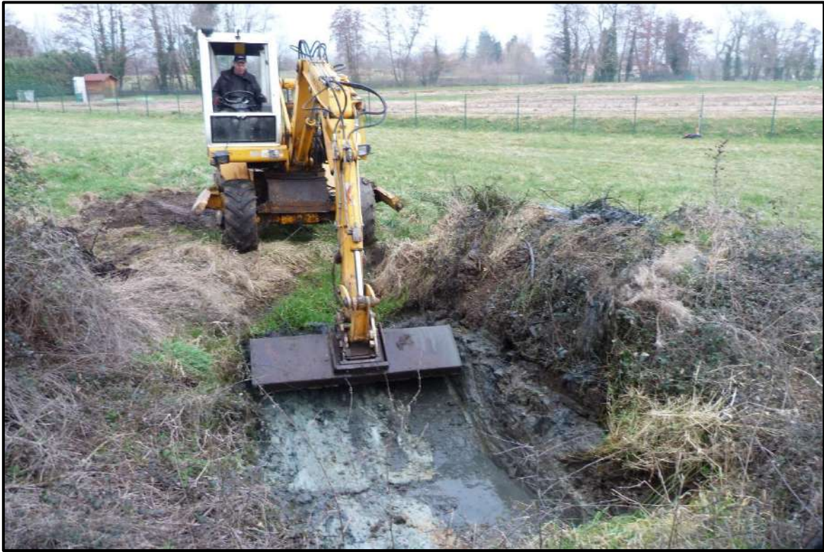
Figure 77 : Mare en cours de restauration © Bertrand Tranchand
