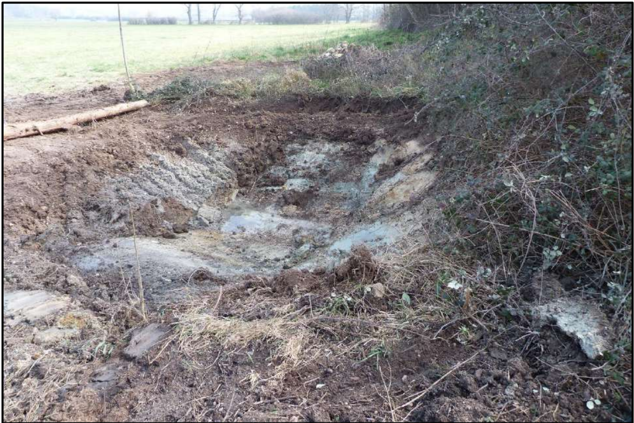
Figure 78 : Mare après l'intervention © Bertrand Tranchand
